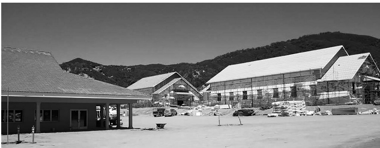
第一期之進度：完成九棟建築之90%
